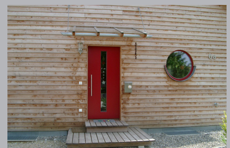
Hauseingang mit Bullauge
